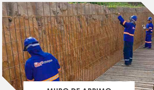
MURO DE ARRIMO
