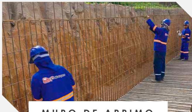
MURO DE ARRIMO
